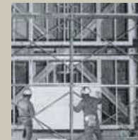
試験体(施工中)全景
